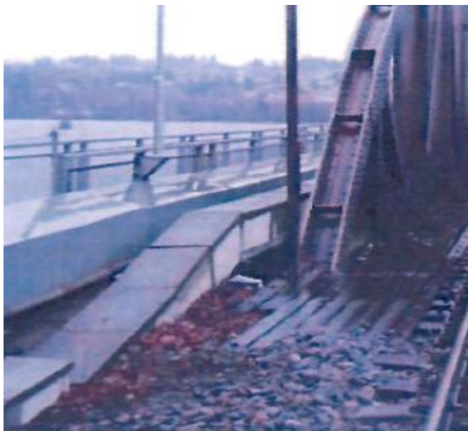
Bilde 4 - Dagens gang/sykkelbane på jernbanebrua ved Fetsund
