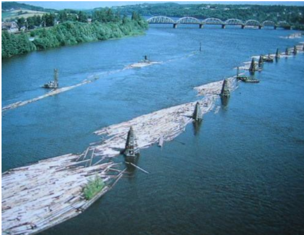
Jernbanebru ved Fetsund
