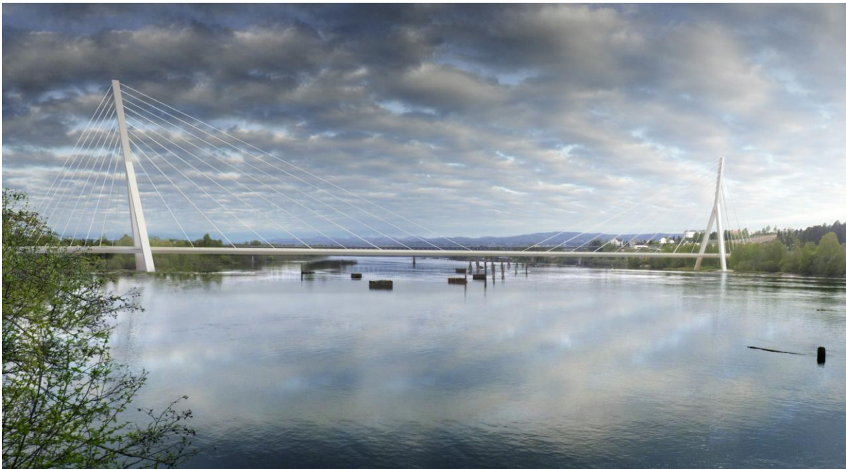
Bru montert inn på foto.
