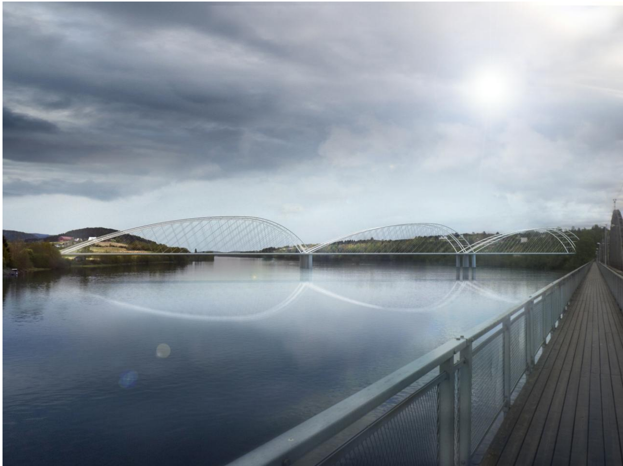
Bru montert inn på foto.
