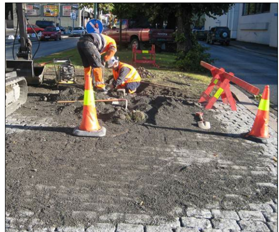
Etterfuging av brosteinsarealer
