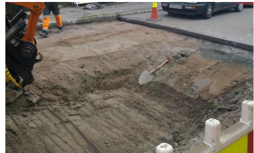
Utkiling med 50 cm kant til asfalt
