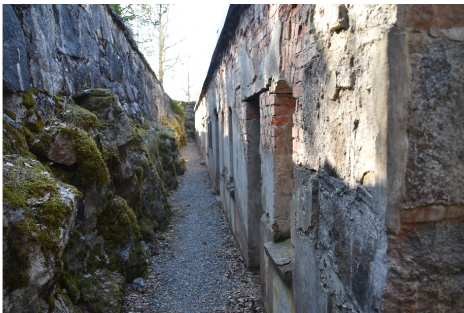
Fra innsiden av fortet.
