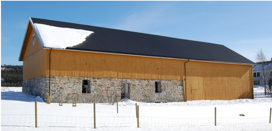
Fjøsset på Haugrim er ett av ytterst få steinfjøs som er bevart i kommunen.
