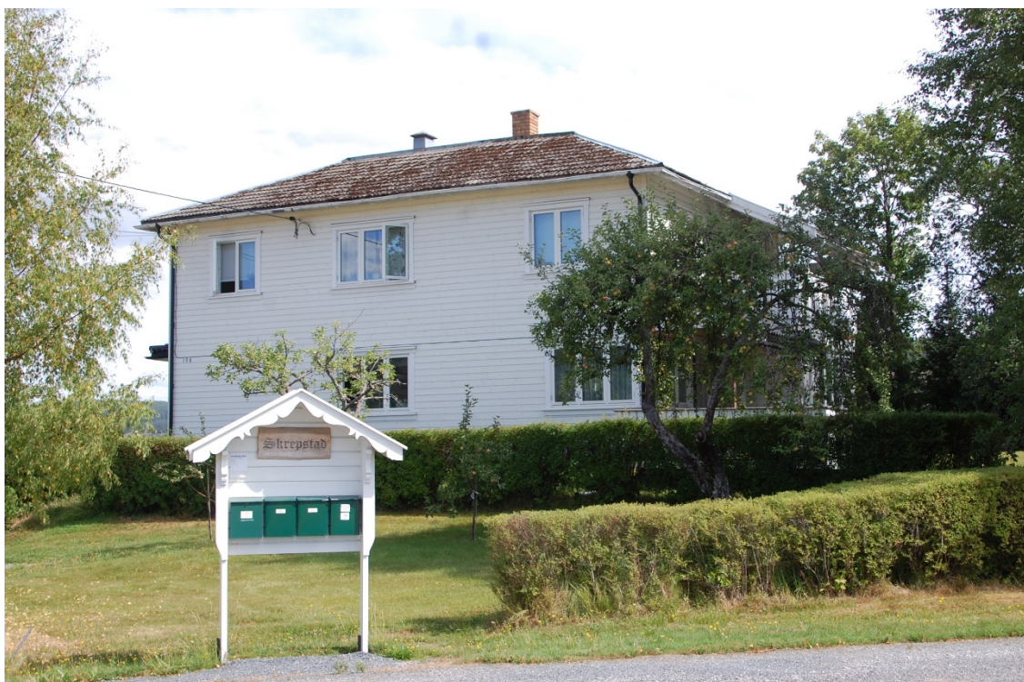
Villa i Haldenveien 198 i typisk utforming for perioden 1930–1950.
