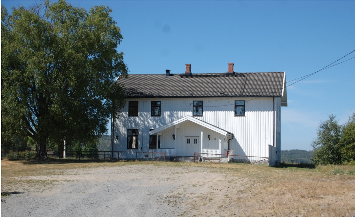
Eikeberg skole. Uthusene har nylig blitt revet.
