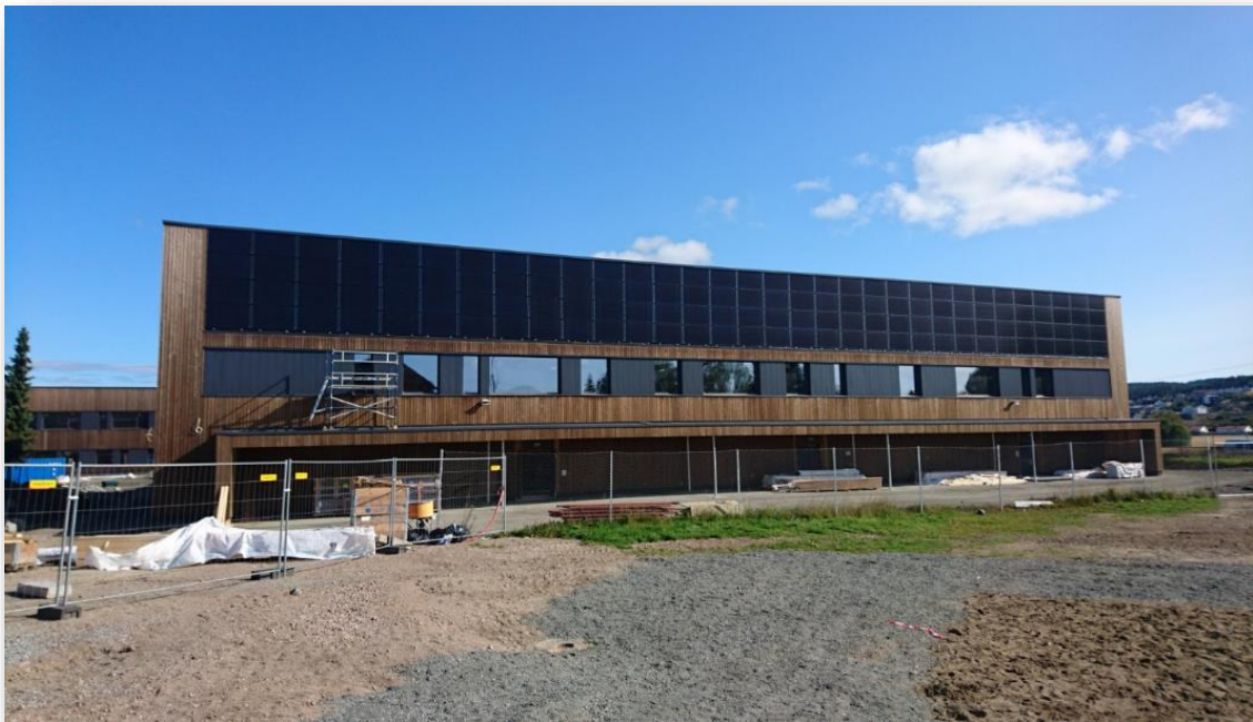
Ny Bjørkelangen skole under bygging i september 2017. Skolen er i massivtre, med solcellepaneler montert på sørvegg av flerbrukshallen (Foto: Ole-Christian Østreng)
