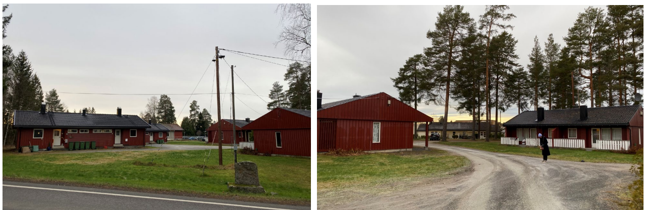
FIGUR 9: EKSISTERENDE BEBYGGELSE I PLANOMRÅDET FRA FYLKESVEI OG KJØREVEI I PLANOMRÅDET
